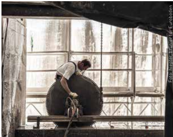
Hochbunker Ungererstraße, München: Schneidearbeiten im Beton mit Spezialgerät während des Umbaus
