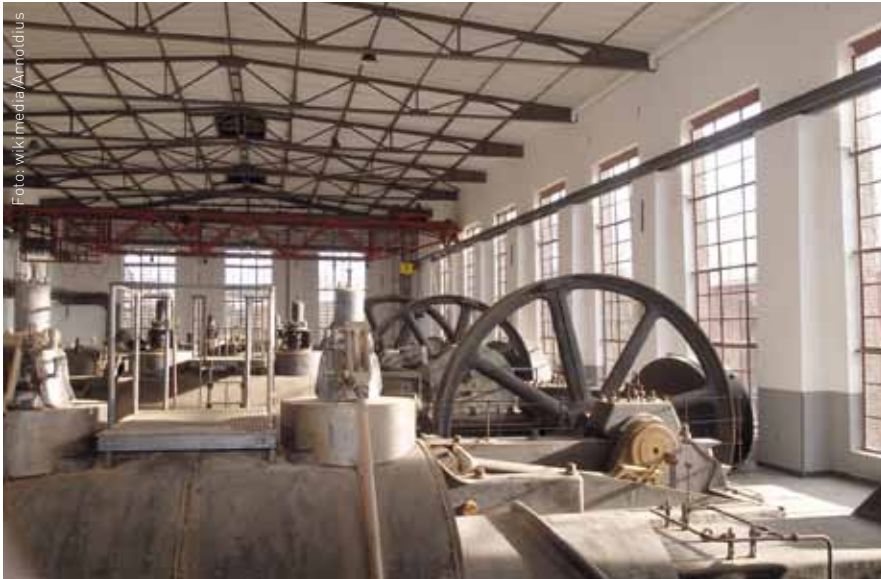
Kompressorenhalle der stillgelegten Kokerei Hansa in Dortmund
